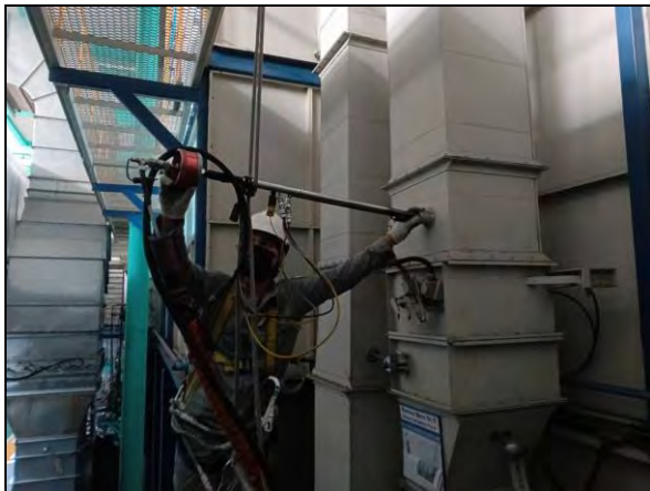
ภาพที่ 9 การเก็บตัวอย่างอากาศจากปล่องระบายอากาศ Exhaust Fan Setting Primer No.5 (Plant C)
