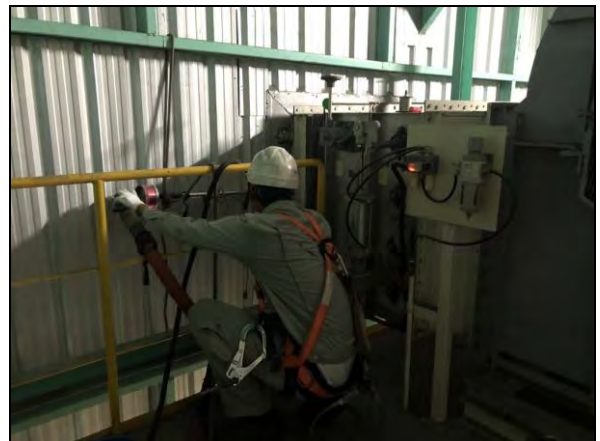
ภาพที่ 12 การเก็บตัวอย่างอากาศจากปล่องระบายอากาศ Exhaust Booth No.1 (Plant E)
