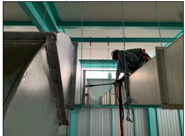
ภาพที่ 10 การเก็บตัวอย่างอากาศจากปล่องระบายอากาศ Exhaust Fan In-Out Oven No.8 (Plant C)
