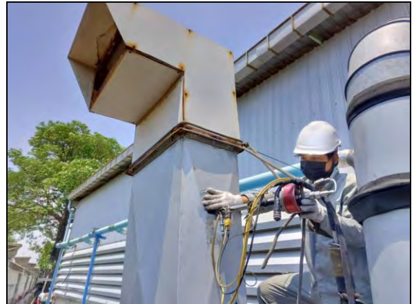
ภาพที่ 16 การเก็บตัวอย่างอากาศจากปล่องระบายอากาศ โรงซัด
