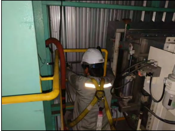
ภาพที่ 13 การเก็บตัวอย่างอากาศจากปล่องระบายอากาศ Exhaust Booth No.2 (Plant E)
